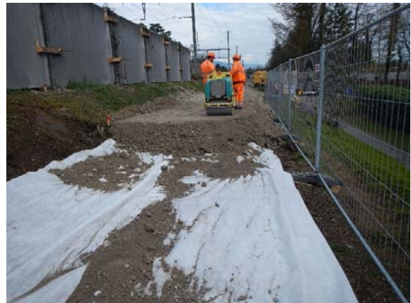
Mise en place de la piste de chantier sur terrain en place (Chambésy)
