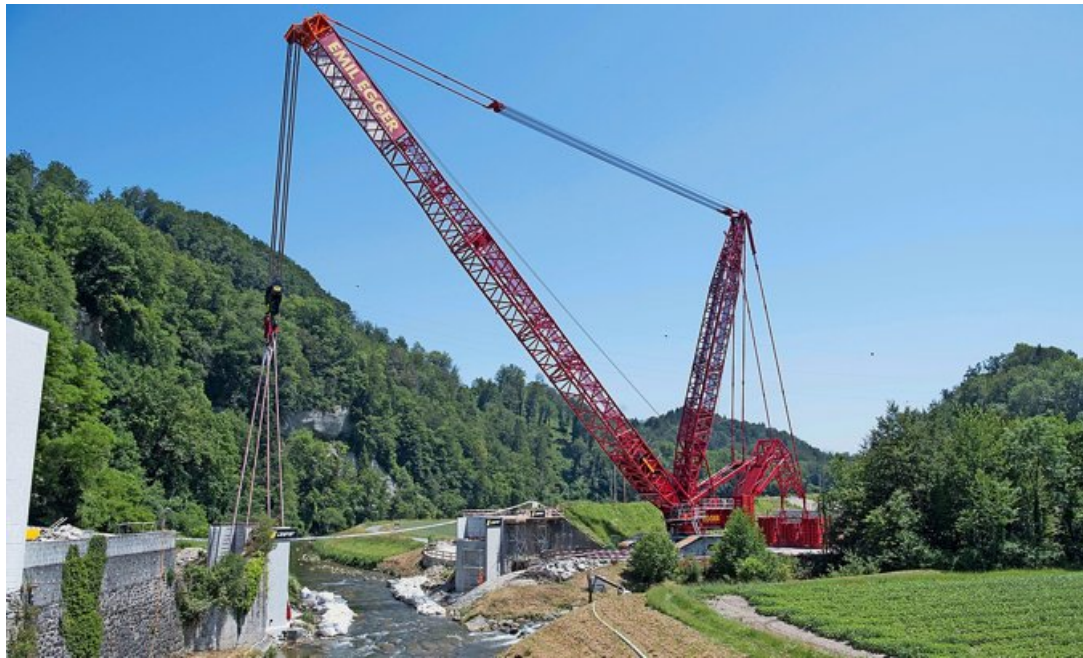
Avant la mise en place du nouveau pont, l'imposante grue de 1600 tonnes a mis en place les deux nouvelles culées du pont de Bressonnaz, à Moudon. JEAN-PAUL GUINNARD
