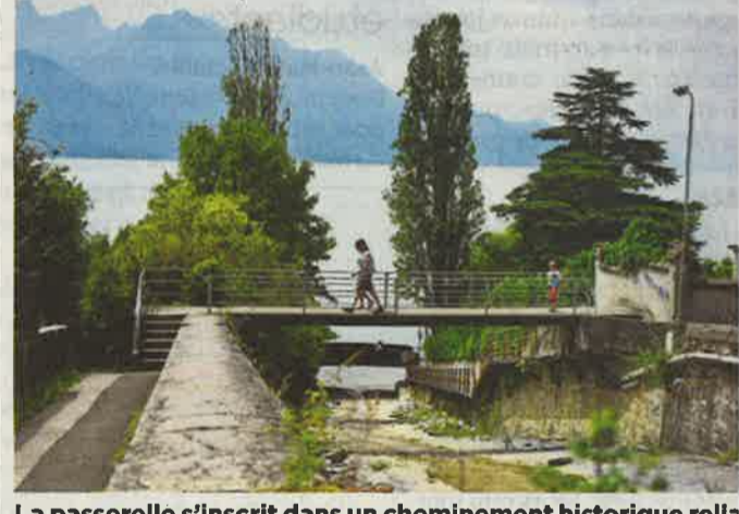
La passerelle s'inscrit dans un cheminement historique reliant Territet et Veytaux. Vétuste, elle sera remplacée. CH. DERVEY
