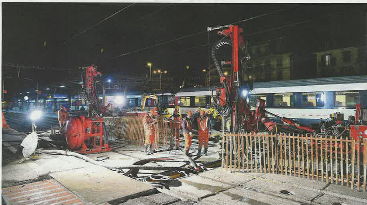
La diminution du bruit à la source est primordiale pour l'acceptation du chantier. DR
